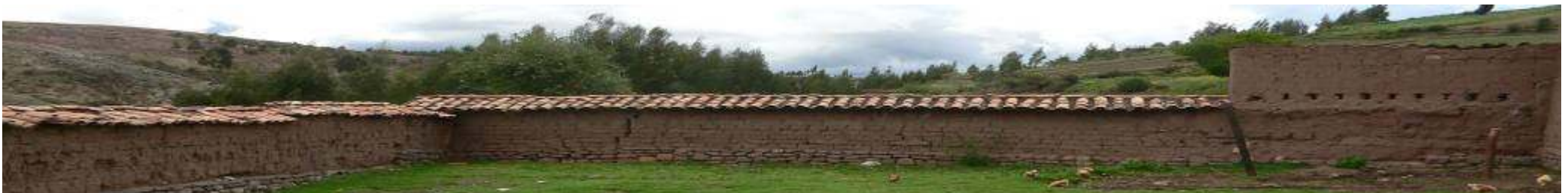
Pared perimetral del oeste
